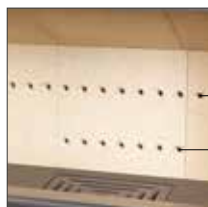
8 Aire terciario o de seguridad. 9 Aire primario precalentado.
